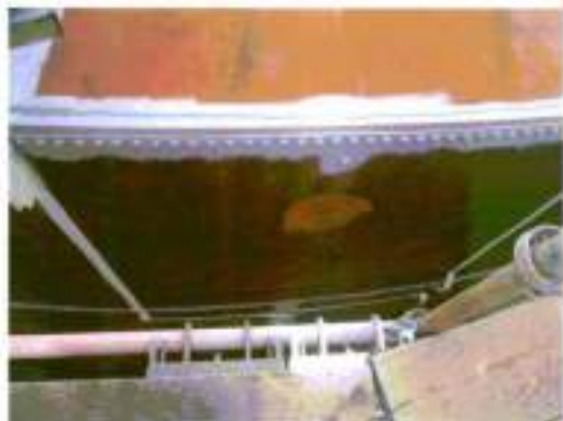
Premaz z trakom Hempadur 15570- Rafinerija: obnova tanka
